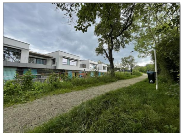
Abbildung 13: Blick 6 von Süden auf die Maison Relais
