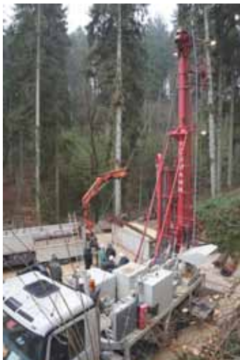
Brunnenbohrung Consdorfer Mühle
