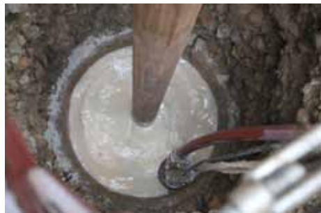
Blick in den Bohrschacht bei ca 3 Meter Tiefe
