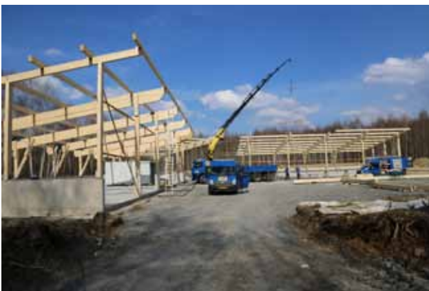
Lagerplatz für Holzhackschnitzel neben der Empfangsstation der Gemeinschaftsantenne im Waldgebiet „Kéidrafft“ an der Staße Mélicksheck-Ousterholz.
