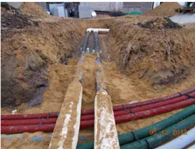
Versorgungsleitungen des neuen Maison-Relais- und Vorschulgebäudes
