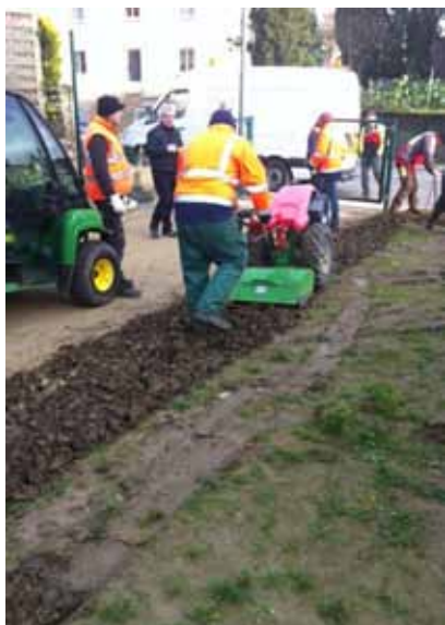
Gemeindearbeiter bereiteten den Boden vor .
