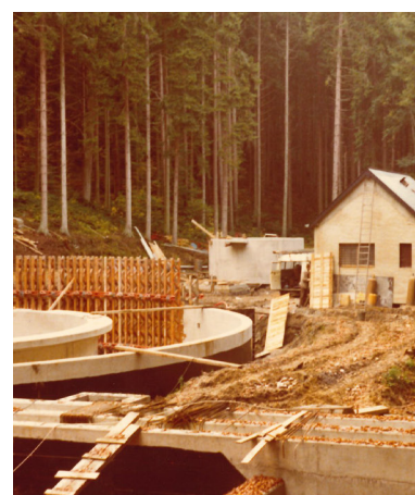
Chantier de la station historique de Consdorf
