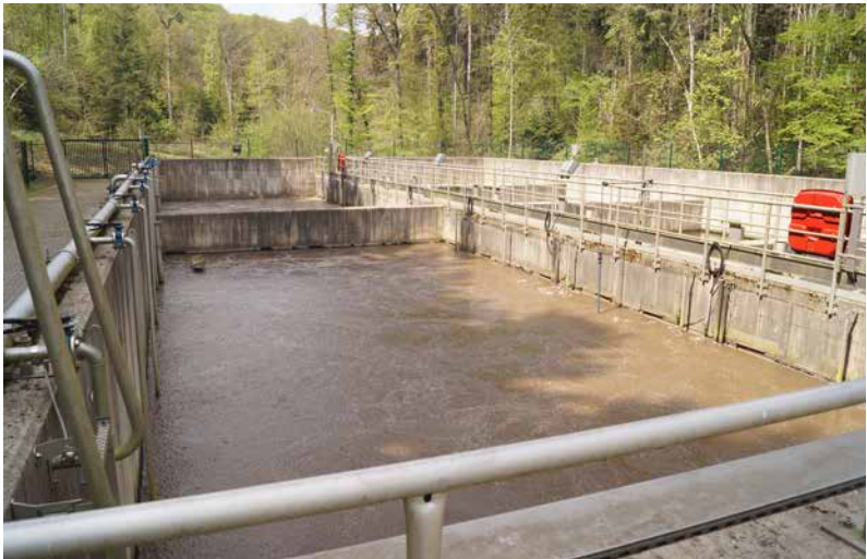
Vue sur le bassin d'activation
