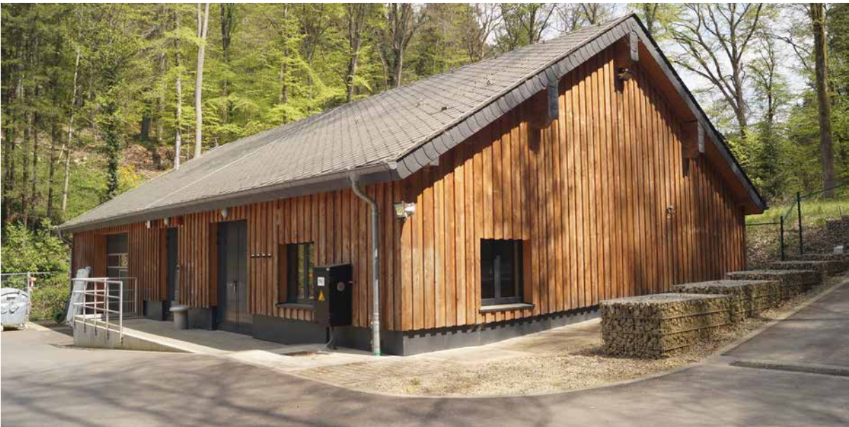
Vue sur le bâtiment de service
