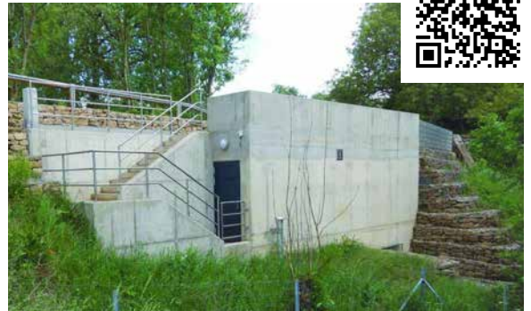
Vue extérieure sur le bâtiment de l'ouvrage
