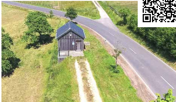
Vue aérienne sur le bâtiment de service
