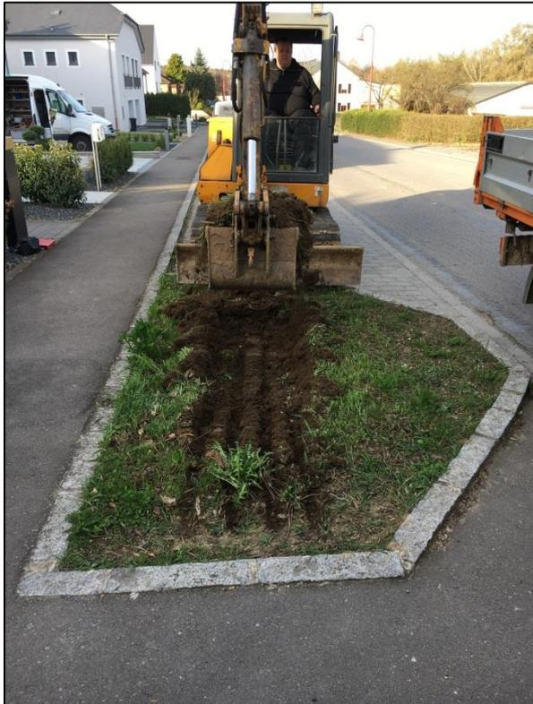
1. Die Fläche vor Beginn der Umgestaltung abmähen. Anschließend wird der Boden auf einer Tiefe von ca. 30 cm entnommen. In dieser Schicht befindet sich die Samenbank vieler Arten, auch solche, die die Entwicklung der Blumenwiese negativ beeinflussen können.
