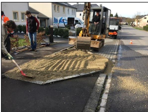
3. Die Fläche wird mit dem gewünschten Material verfüllt. Auf der Abbildung handelt es sich um eine Mischung aus Kalkschotter (0/8 – 0/16) und Schwemmsand.
