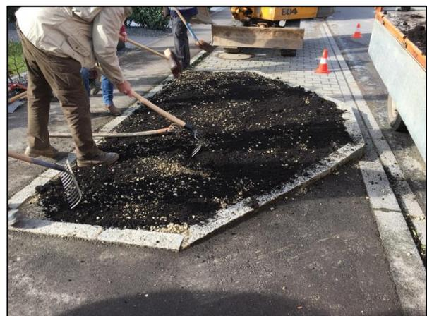
4. Auf die Mischung aus Schotter wird eine ca. 2-3 cm dicke Schicht mit Kompost aufgetragen und vermischt.
