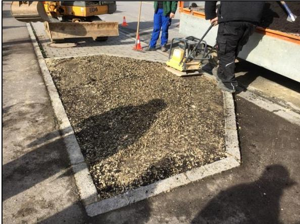
5. Das Material mit einer Rüttelplatte befestigen. Anschließend kann die Oberfläche wiederum leicht aufgekratzt werden um einen besseren Halt des Saatgutes zu gewährleisten.
