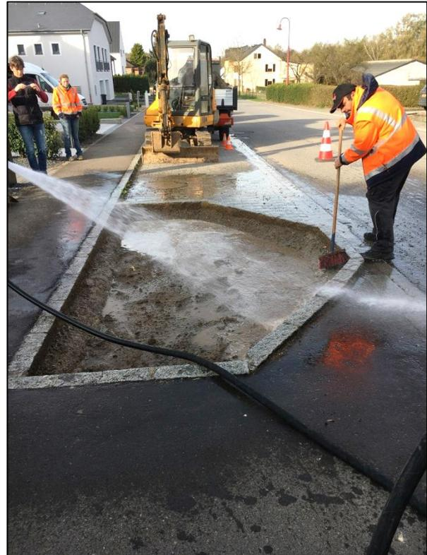
2. Nach der Entnahme des Bodens, müssen die Bordkanten und Fugen gut gereinigt werden um verbleibende Wurzeln und Samen zu entfernen.
